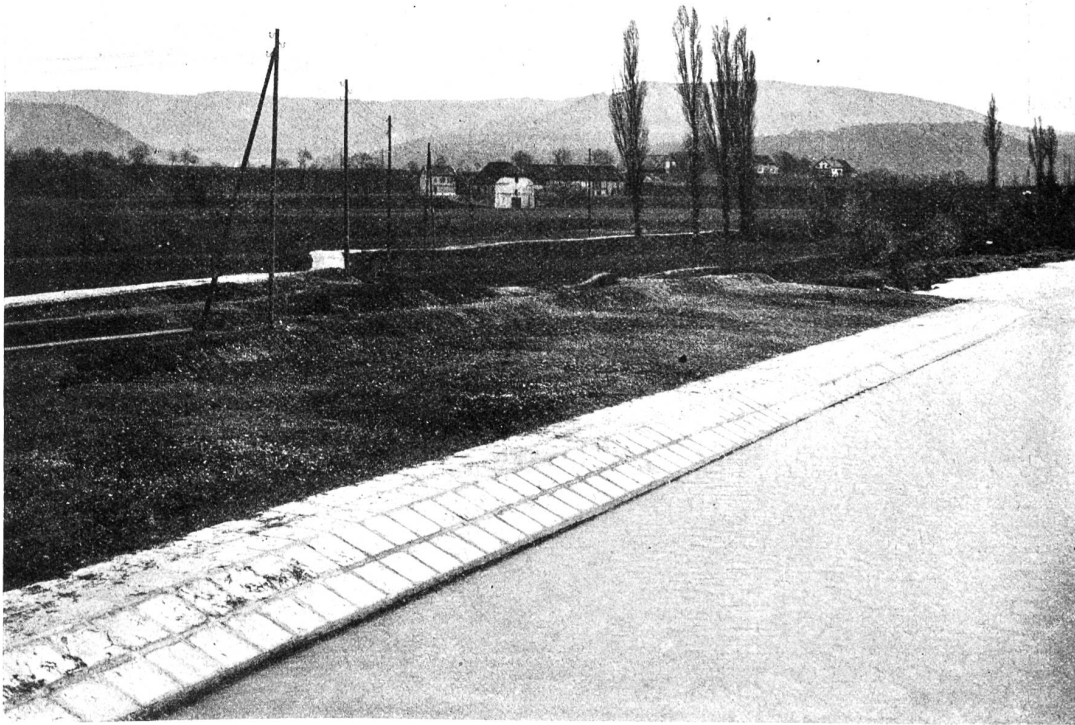
Uferschutzarbeiten. Abbildung 4. Birsuferverbauung Birsfelden, ausgeführt 1911.
