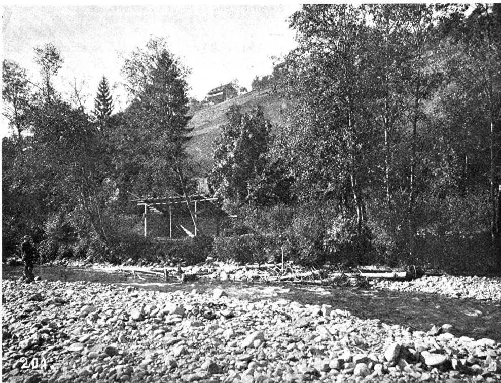
Technique hydraulique. Lit de la Zulg avant les travaux.
