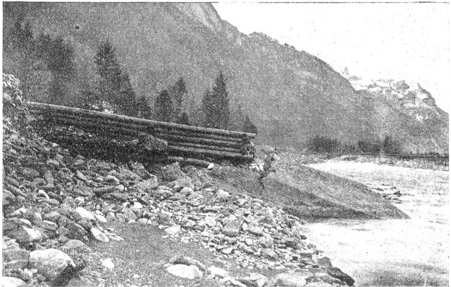
Die Muotakorrektio. Abb. 17. Holzsporren mit Betonkopf.
