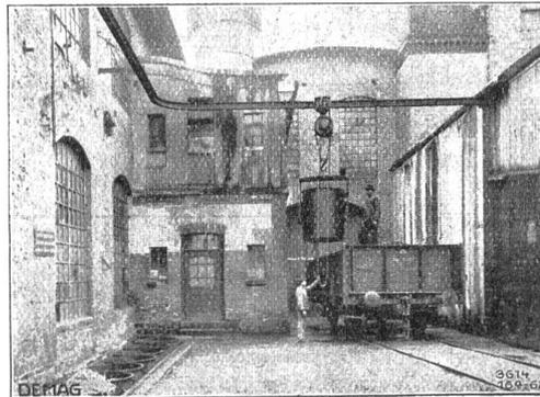
Abb. 4. Elektro-Flaschenzug mit Laufbahn.
