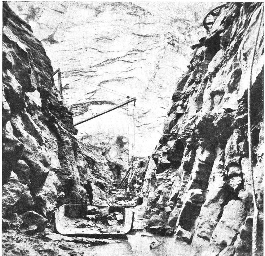
Abb. 7. Damm-Fundament; Dorn-Einschnitt am talseitigen Rand (Damm-Zehe).
