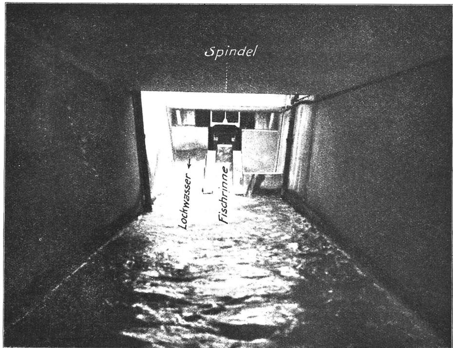
Abb. 13. E.-W. Augst. Oberste Rinne mit beweglichem Einlaufstück.
