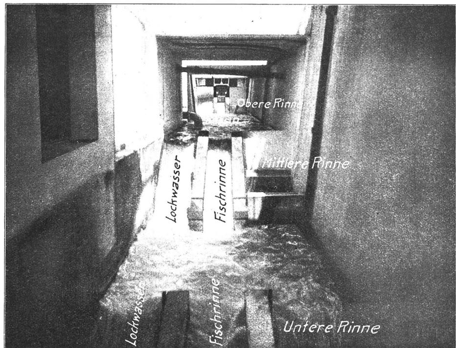
Abb. 14. E.-W. Augst. Oberer Lauf der Deniltreppe.
