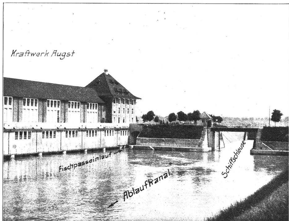
Abb. 16. E.-W. Augst. Ausmündung der Deniltreppe im Unterwasser.
