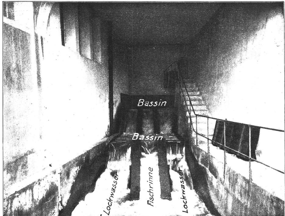
Abb. 15. E.-W. Augst. Unterer Lauf der Deniltreppe.
