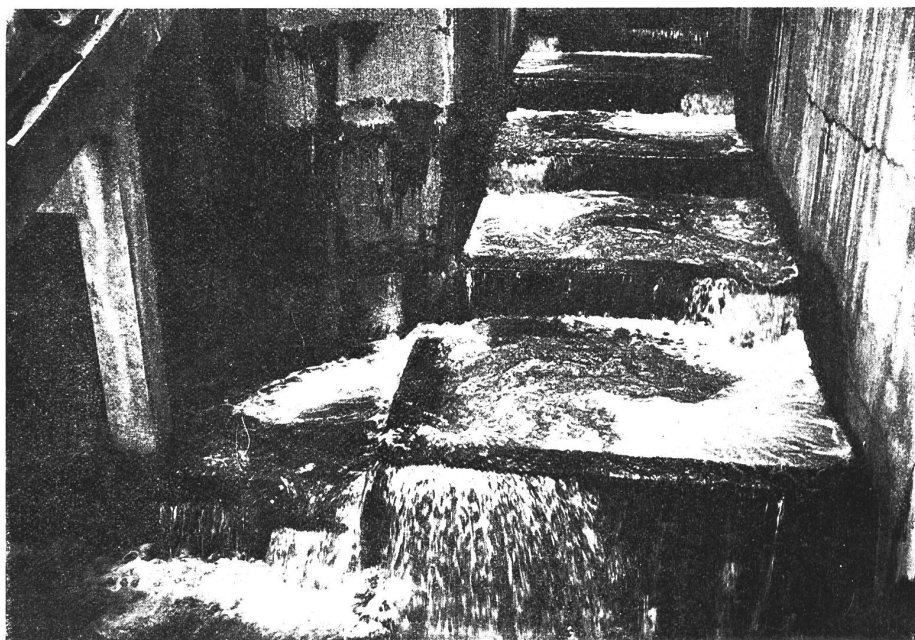
Abb. 30. Stauwehr des Elektrizitätswerks Kallnach. Teil der Fischtreppe, von oben gesehen.
