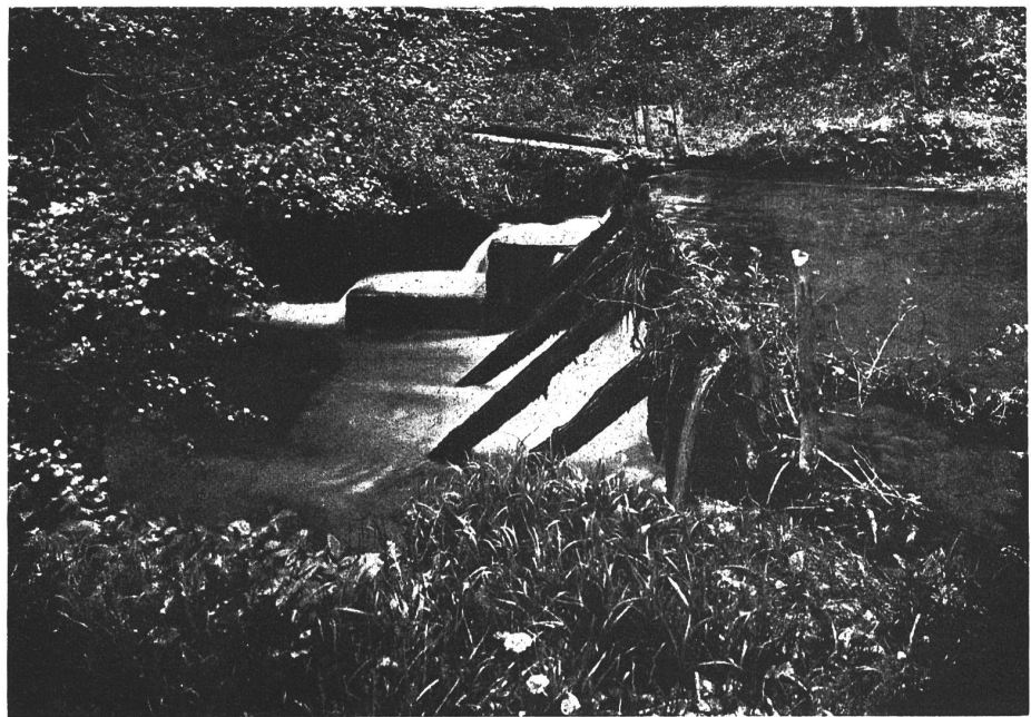
Abb. 64. Barrage de la Tuilerie Marenday à Method. Echelle à poissons sur la rive droite.
