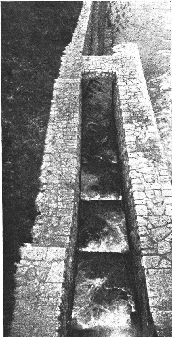
Abb. 80. Stauwehr des Elektrizitätswerkes Aue (Baden). Ansicht des untern Teils des Fischpasses von oben.
