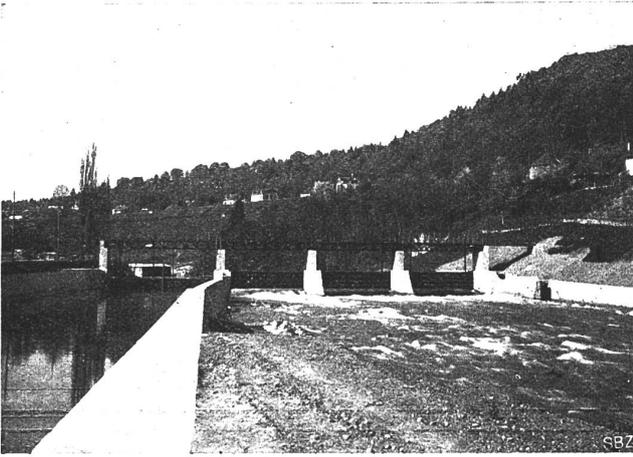
Abb. 79. Elektrizitätswerk Aue (Baden). Ansicht des Stauwehres vom U. W. aus mit Fischtreppe auf dem linken Ufer.
