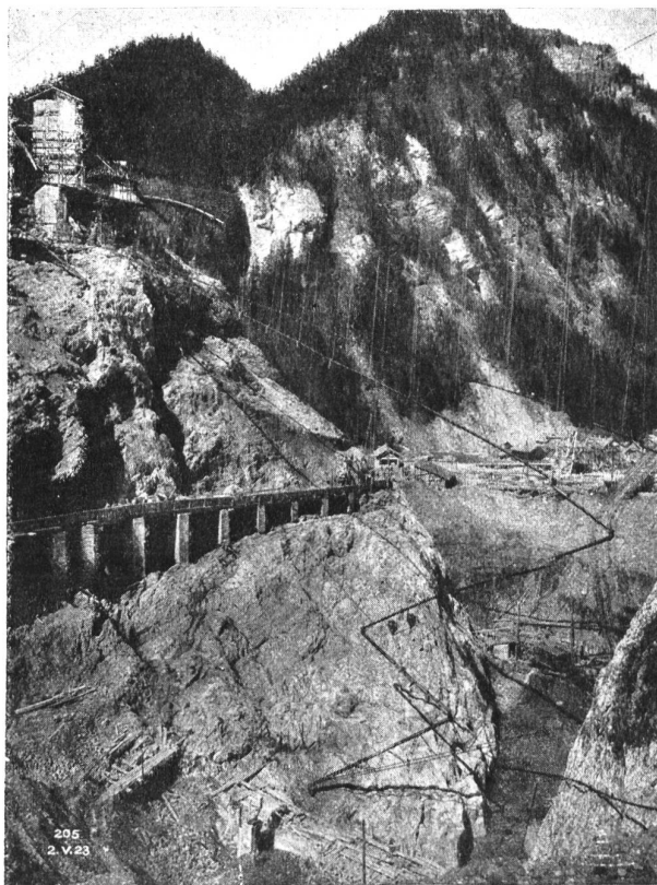
Abb. 3. Kraftwerk Wäggital: Betonrinnen zum Bau der Staumauer.
