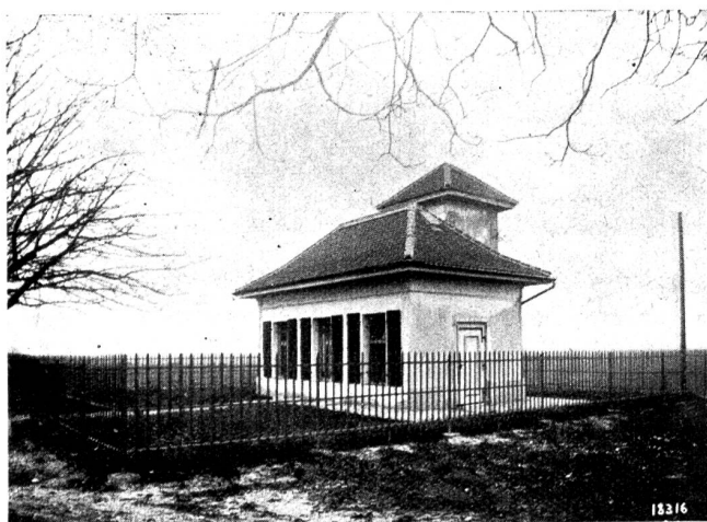
Abb. 11. Pumpwerk Nidaumoos. Ansicht der Anlage.
