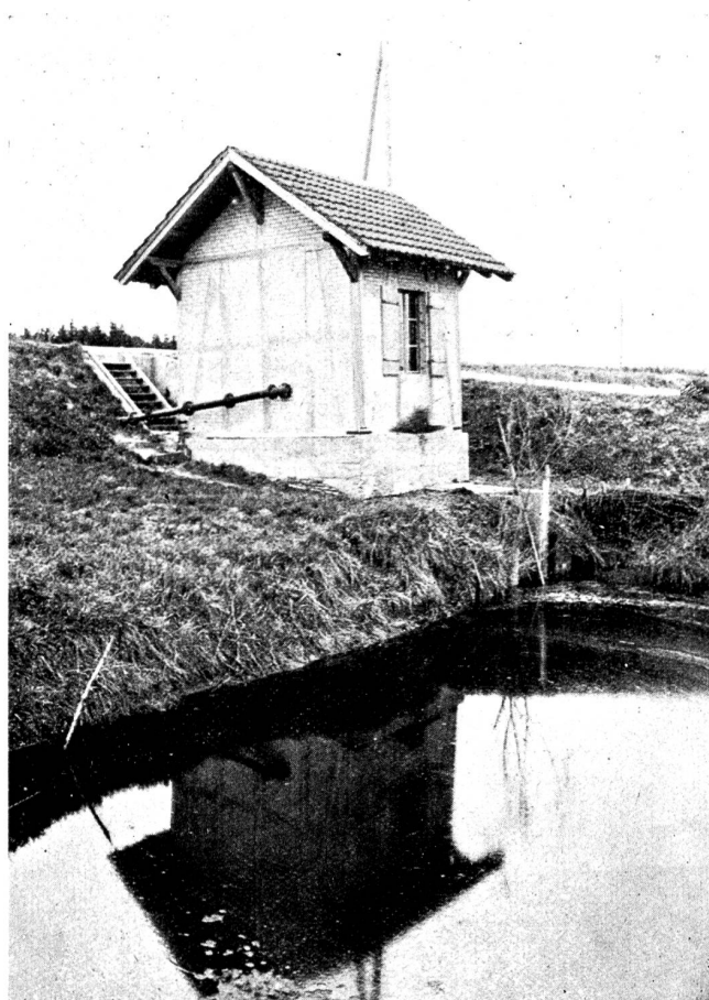
Abb. 29. Pumpstation Hagneck. Ansicht der Anlage.
