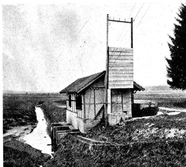
Abb. 30. Pumpstation Täuffelen. Ansicht der Anlage.
