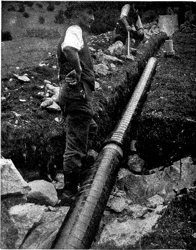
Leitung aus Rohreinheiten zusammengesetzt.
