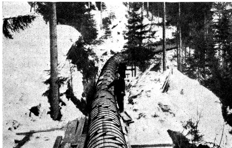
Dem Gelände angepasste, kontinuierliche Leitung im Zillertal.
