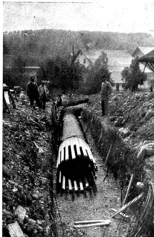
Im Bau begriffene, kontinuierliche Leitung im Schwarzwald.
