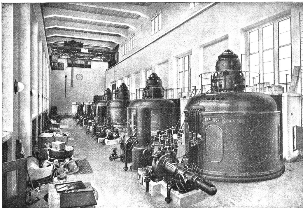
Abb. 24. Wäggital. Inneres der Zentrale Siebnen.
