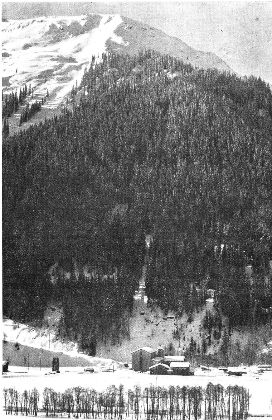
Abb. 36. Klosters. Ansicht der Zentrale und Druckleitungs-Tracé.
