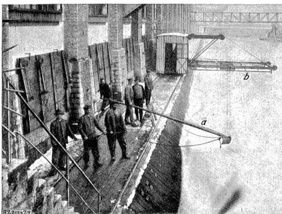
Abb. 7. Alte Reinigungsharke *a* und Rechenreinigungsmaschine *b* von 1911 mit 4 m breiter Krücke.
