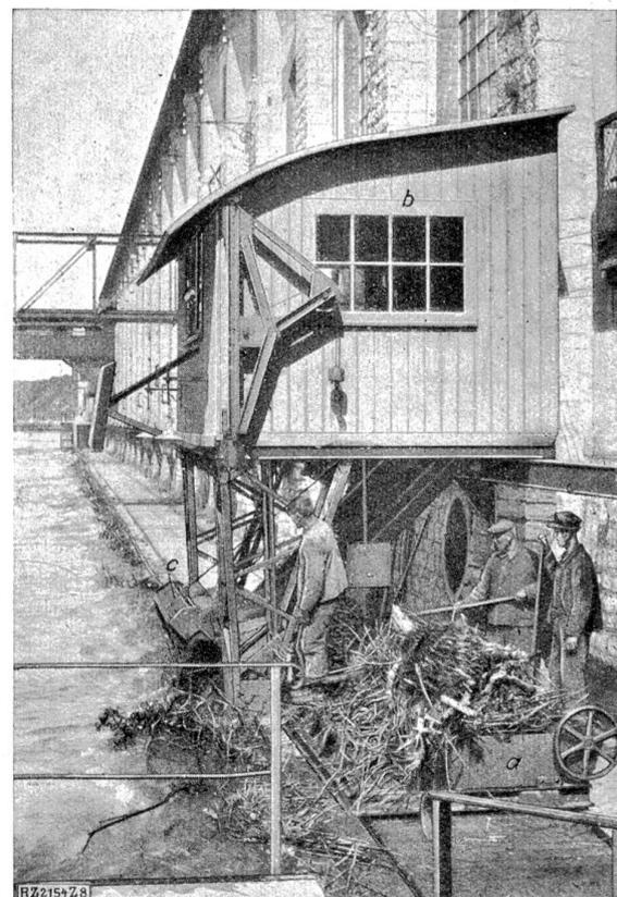
Abb. 8. Rechenreinigungsmaschine, Bauart Jonneret. *a* Abfuhrwagen für das Rechengut *b* Rechenreinigungsmaschine *c* Putzwagen.
