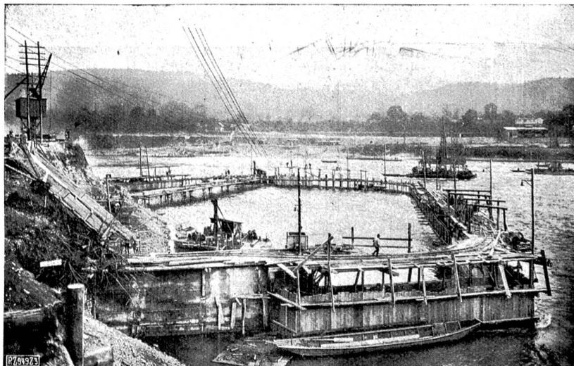
Abb. 3. Blick von Oberstrom auf die Wehrbaugrube am linken Seeufer, Fangdammarbeiten.
