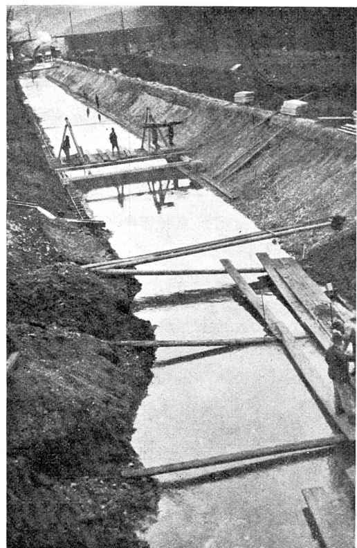
Abb. 2. Rammwagen für die Pfählung.
