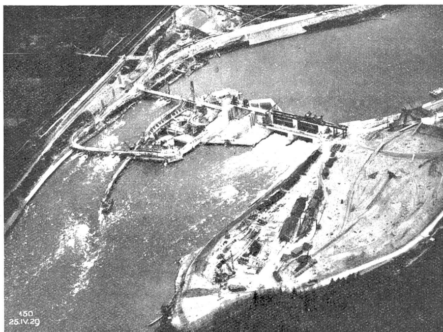
Abb. 2. Erste zwei Wehröffnungen fertig, anschließend Baugrube für linke Maschinenhaushälfte.
