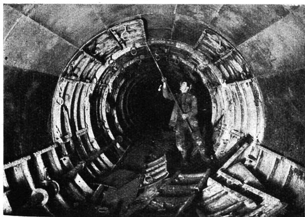
Abb. 8. Kraftwerk Piottino. Ausschalen der Stollenverkleidungen.
