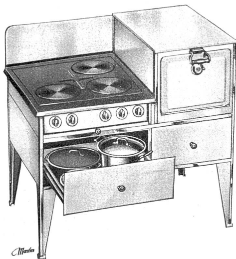
Abb. 39 Elektrischer Kochherd Fabrikat: Maxim A.G., Aarau
