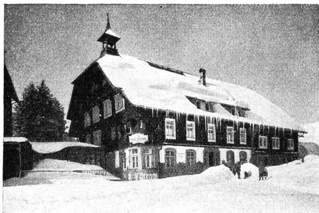
Abb. 25 Schneewächten hinter dem Schneefang
