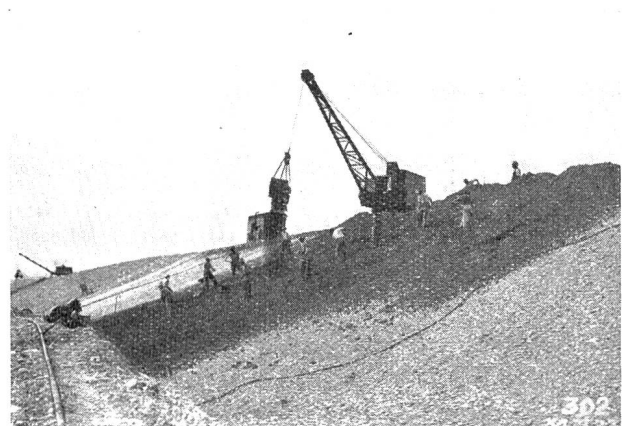
Abb. 6. Kraftwerk Klingnau. Linksseitiger Stauseedamm unterhalb Gippingen, Wasserseite. Einbringen und Verteilen des Leimes für die Dammabdichtung mittelst Greifer und Handarbeit auf der Böschung als Vorbereitung für die Walzung.
