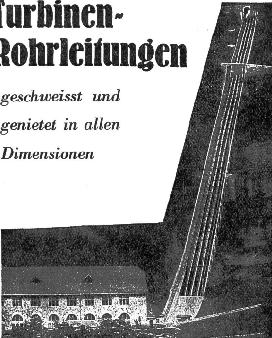
Kraftwerk Amsteg, Lieferung und Montage der 3. Druckleitung und der Leerlaufleitung
