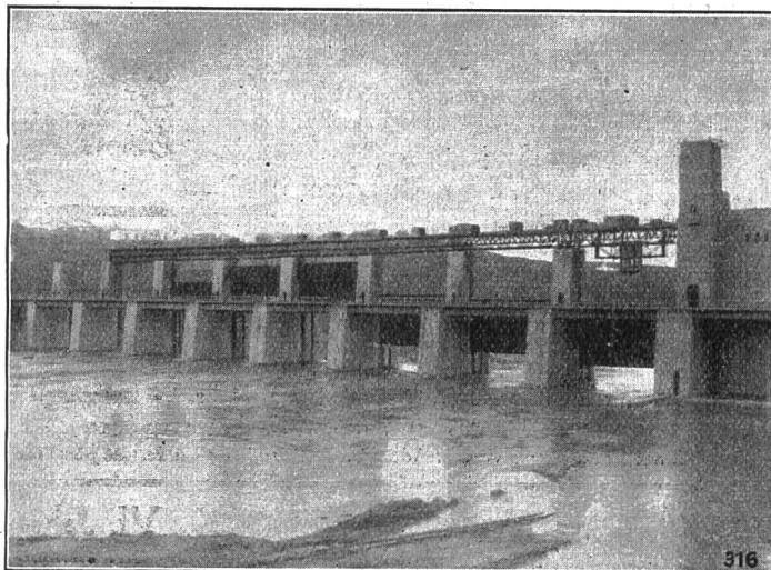
Wehranlage Alcala del Rio im Guadalquivir
