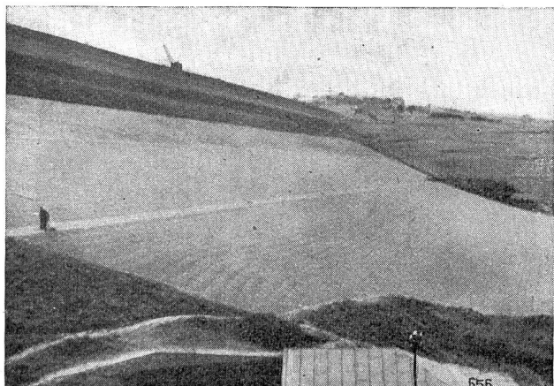
Abb. 4. Sorpetalsperre. Ansicht von der Luftseite.
