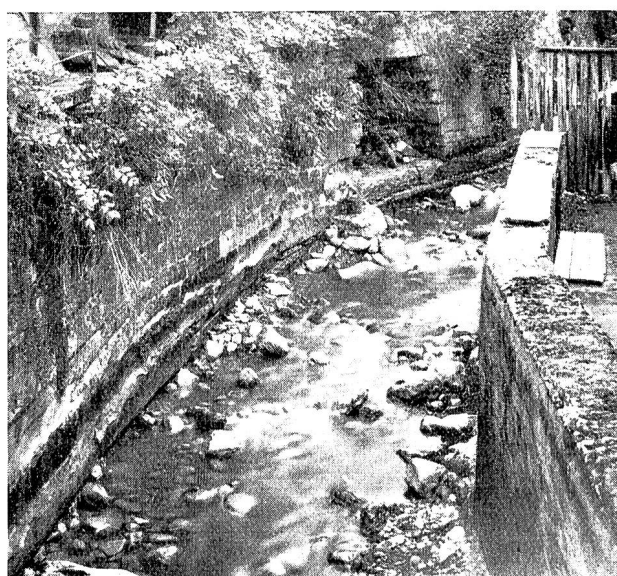
Abb. 9 Der Mühlebach bei Richterswil. Sohlenvertiefung im oberen Dorfteil (Kesselschmiede) Erosion du sol du «Muhlebach» près Richterswil (haut-village)
