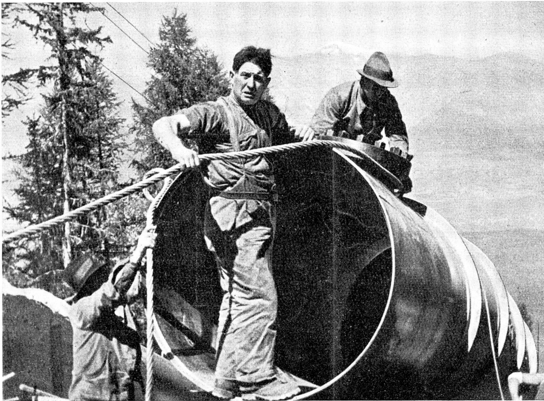
Abb. 13 Erstellen der Druck- leitung des Dixence- Kraftwerkes (Wallis) (Aus dem Film: Unsichtbare Kraft)
