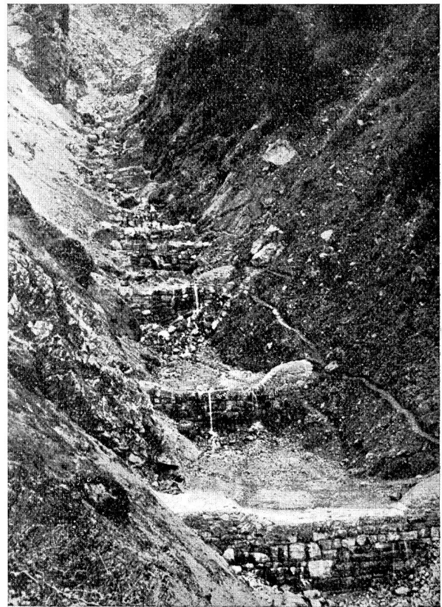
Abb. 47 Guppenruns bei Schwanden. Sperrenbauten in der Sienenschlucht.
