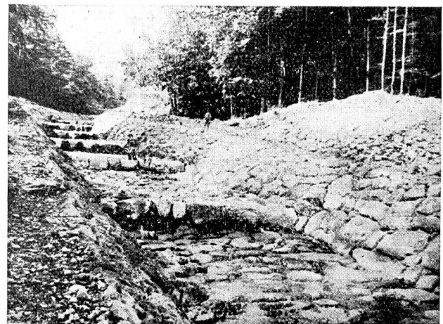
Abb. 48 Schalenbau am Biltner Dorfbach.
