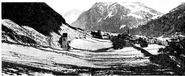
Abb. 74 Bergsturzgebiet bei Linthal (Kilchenstock) 7. November 1932.
