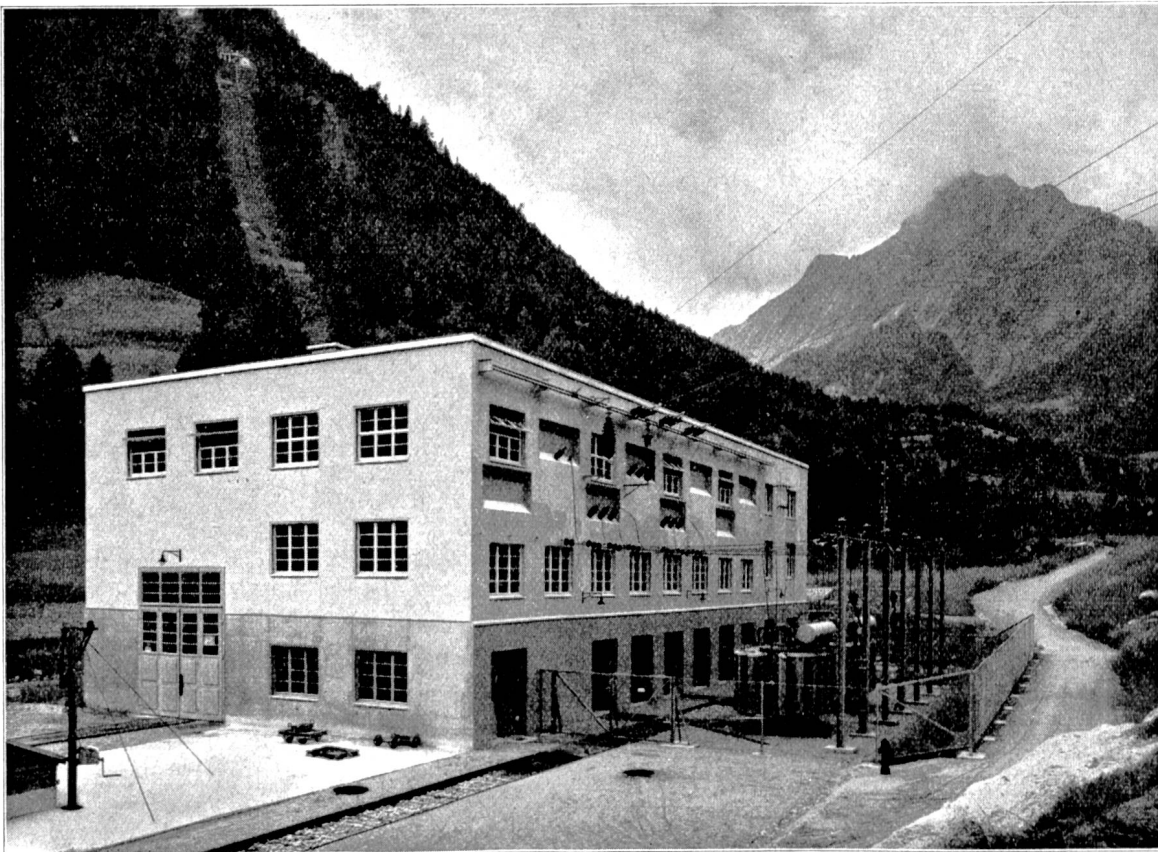
Abb. 48 Kraftwerkgebäude, äussere Ansicht gegen die Transformatorseite (Cliché Bulletin tech. Suisse Romande).
