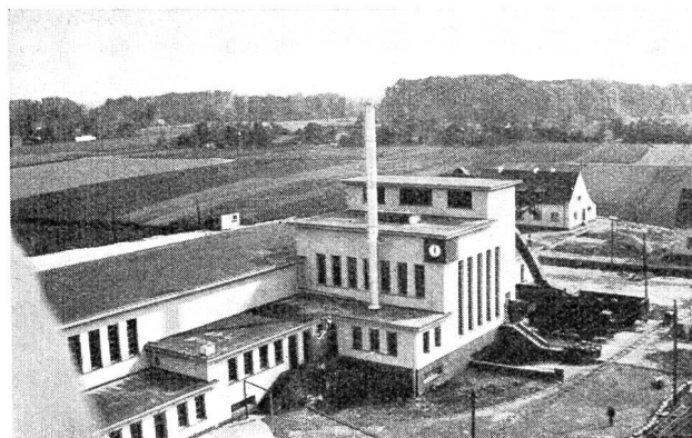
Fig. 53 Centrale à vapeur avec production d'acide carbonique (Niers).
