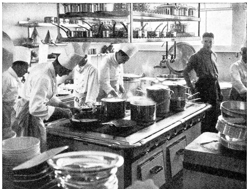
Fig. 53 Blick in die elektrische Küche im Pavillon Suisse an der Weltausstellung in Paris.
