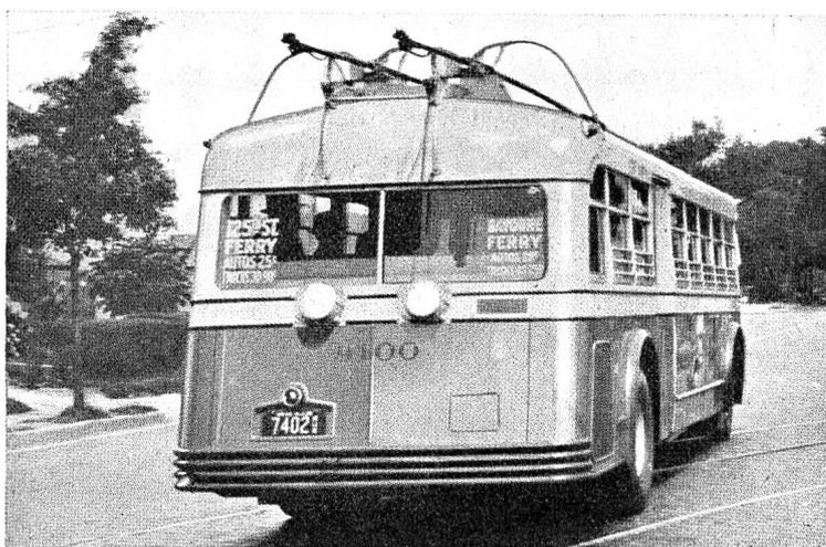
Abb. 33 Endgültige Bauart des in Newark entwickelten Zweikraftwagens. Das Bild zeigt einen der 430 vorhandenen Wagen mit abgezogenen Stromabnehmern als Dieselbus laufend.
