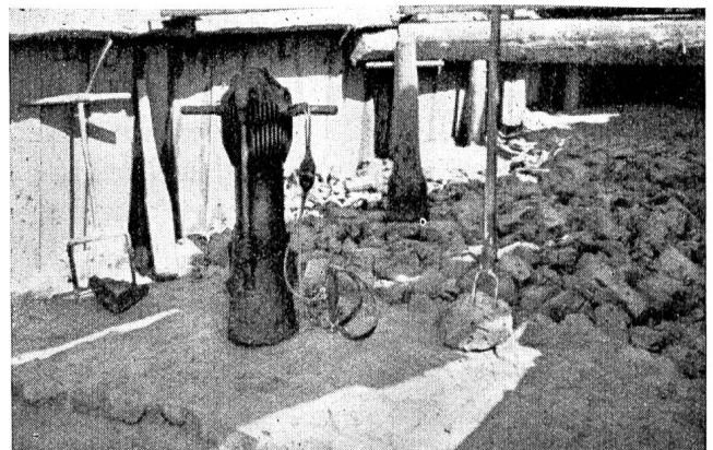
Abb. 83 Hübnermattdamm. Lehmkern im Schlitz.
