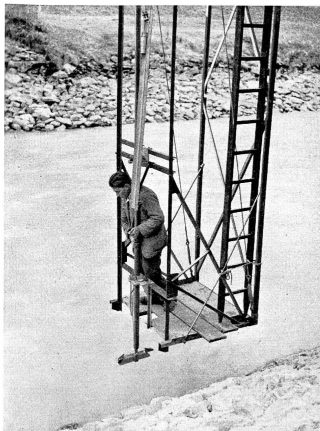
Abb. 117 Klappenschöpfgefäss vom Wassermesswagen aus benützt.
