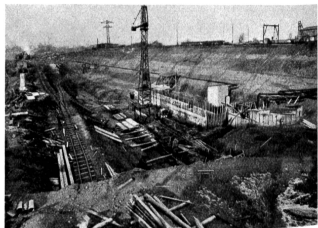
Abb. 6 Kraftwerk Reckingen Baugrube für das Krafthaus, Wasserhaltung 5 m unter Rheinspiegel.
