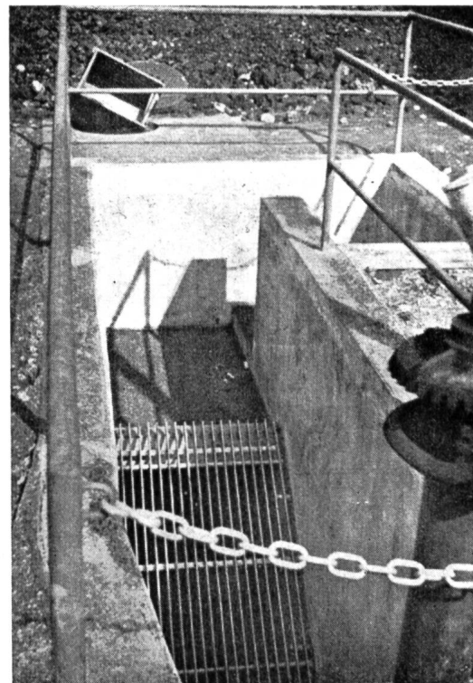
Abb. 3 Einlauf zum neuen Zulaufkanal mit Grobrechen.
