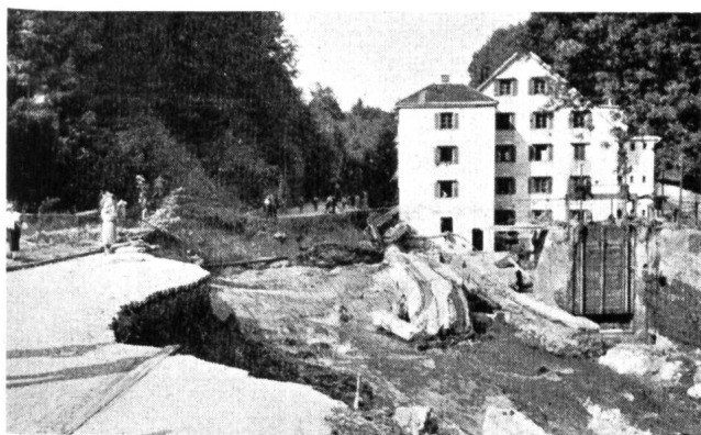
Abb. 5 Die Aussdrümmung als Folge des Dammbruches im Tiefenhof (s. Abb. 4).
