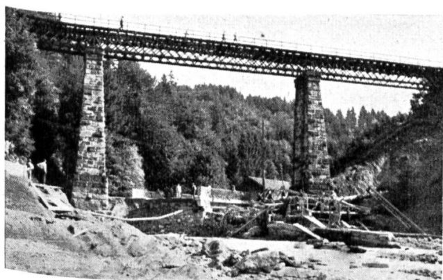
Abb. 6 Die Holzansammlung am Fallgestell eines Wehres (Grundtal) und deren Folgen.
