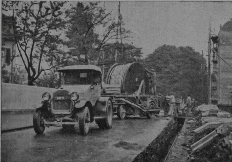
Verlegung von 6-kV-Kabeln 3 \times 240 \text{ mm}^2 für das Elektrizitätswerk der Stadt Bern.
