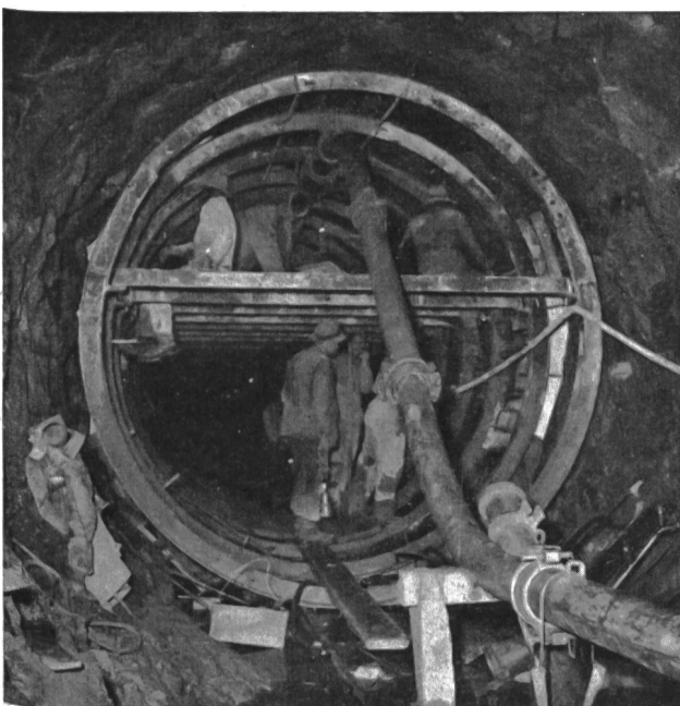
Abb. 3 Kraftwerk Innertkirchen. Betonierung des Zulaufstollens.
