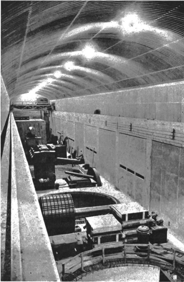
Abb. 12 Zentrale Innertkirchen. Ansicht des Maschinenraumes im Bau, März 1942.
