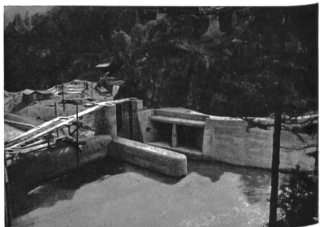
Abb. 2 Kraftwerk Gampel III. Wasserfassung mit Stolleneinlauf und Grundablass im Hintergrund der Entsander. (Nr. 6398 BRB 3. 10. 39.)
