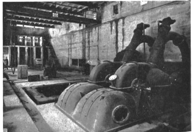
Abb. 7 Zentrale Gampel III. Turbine I montiert; im Hintergrunde die Schaltanlage.
