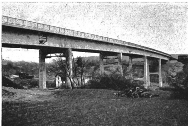
Fig. 4 Le Verbois. Nouveau pont de Peney. (Nr. 6398 BRB 3. 10. 39.)
