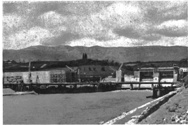
Fig. 1 Le Verbois. Partie centrale du chantier, vue de l'aval. (Nr. 6398 BRB 3.10.39.)
