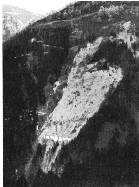
Abb. 8 Verbauung der Bilddole. Vollendete Lehnmauer, Aufnahme Dezember 1942. (Nr. 7828 BRB 3. 10. 39)
