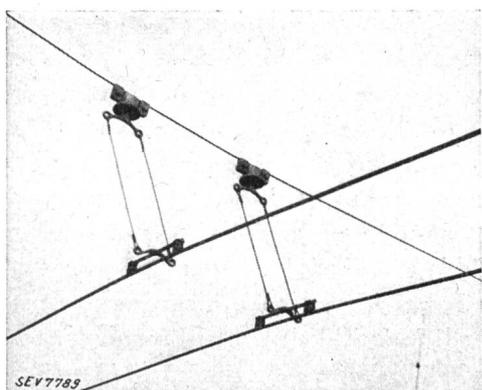
Fig. 6 Suspension pendulaire du fil de contact.
