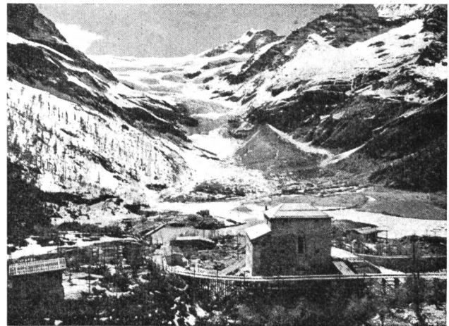
Abb. 3 Speicherkraftwerk Palù der Kraftwerke Brusio A.-G., mit dem Ausgleichbecken. Im Hintergrund Piz Palù mit Gletscher. (Nr. 7141 BRB 3. 10. 1939)
