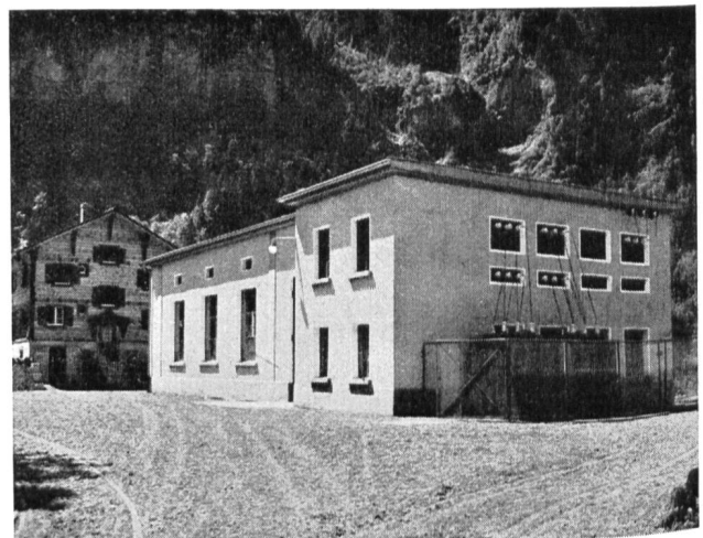
Abb. 13 Zentrale Oberrickenbach des Bannalpwerkes
