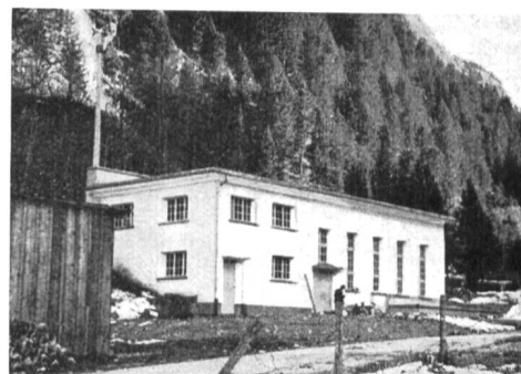
Abb. 10 Kraftwerk Tagenstal, Ansicht der Zentrale.
