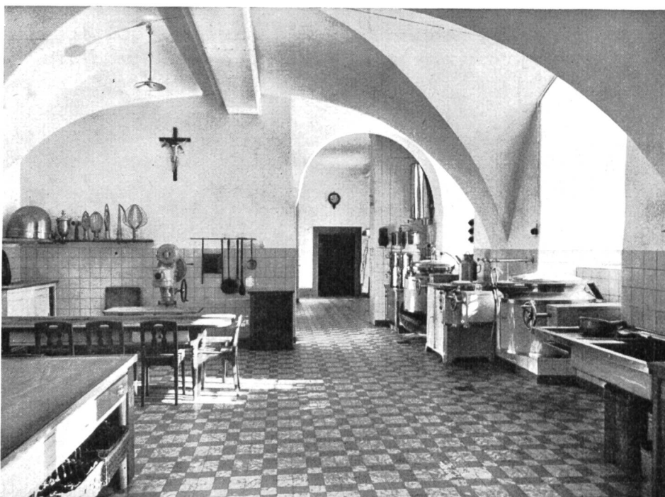
Fig. 29 Klosterküche Engelberg. Kippkessel, Autoklav und Kaffeemaschine.
