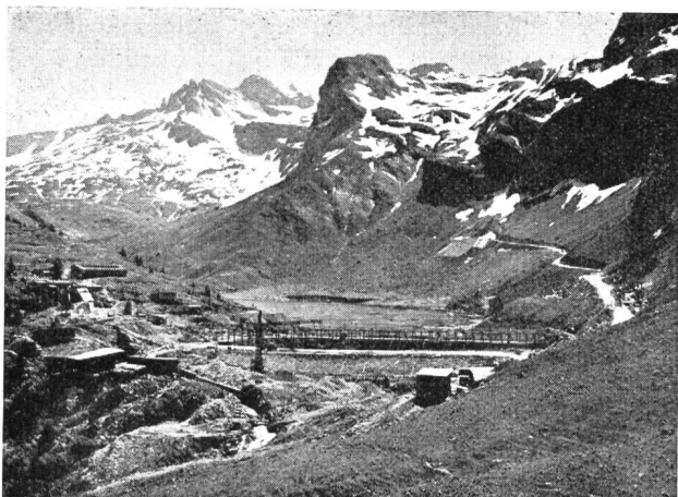
Abb. 14 Bannalpwerk, Baustelle am 15. Juni 1937. (Nr. 6398 BRB 3.10.39)
